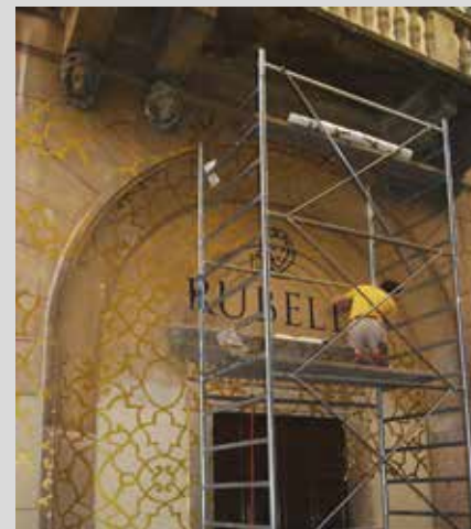
Fasi di lavoro con utilizzo impalcatura mobile
