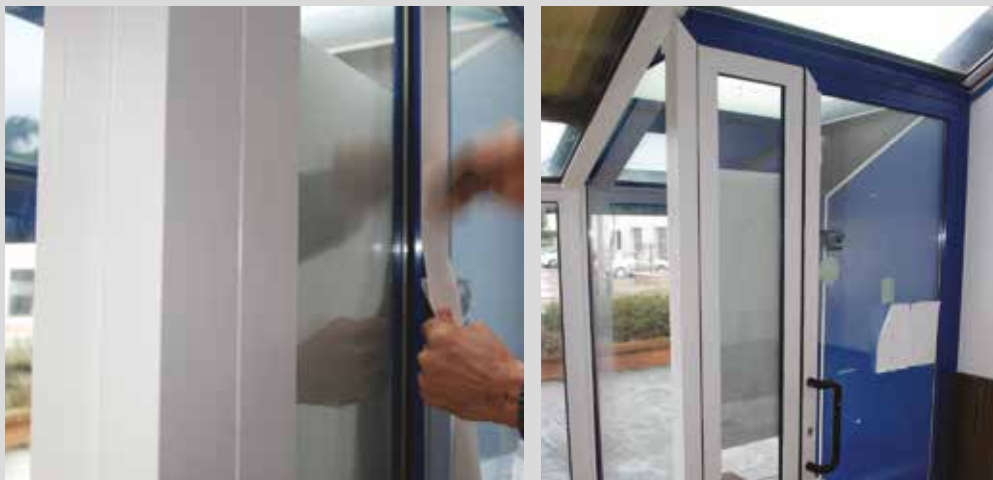
Fasi di copertura degli infissi
