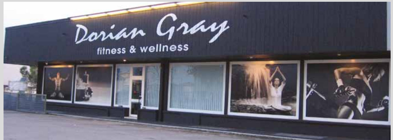
Copertura totale vetrate
