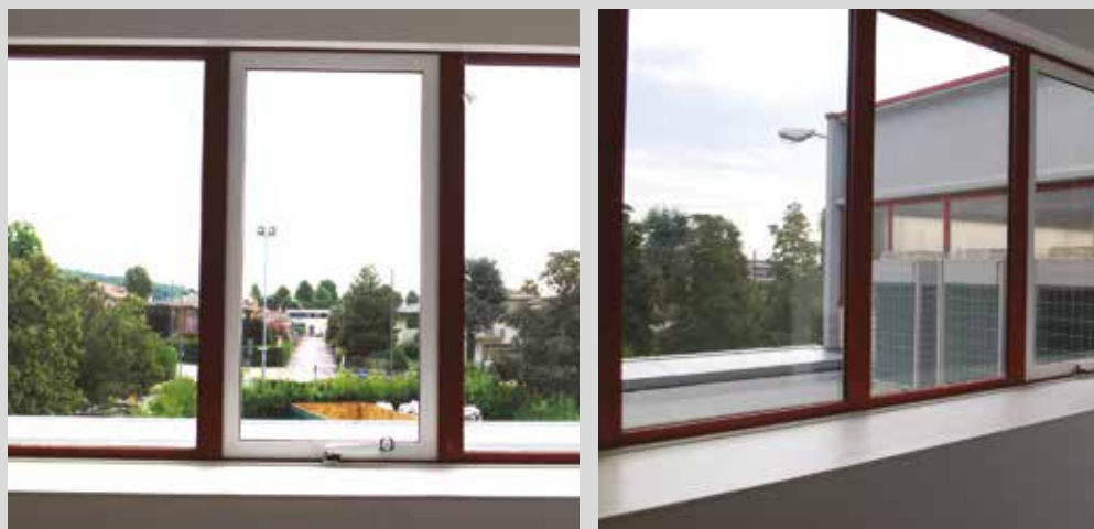
Fasi di copertura degli infissi
